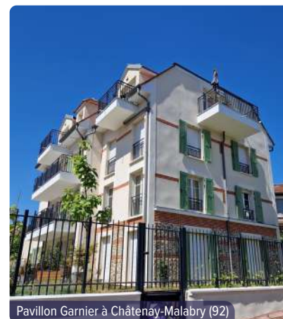
Pavillon Garnier à Châtenay-Malabry (92)
