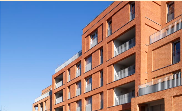
Résidence Live In Osmose - Toulouse
