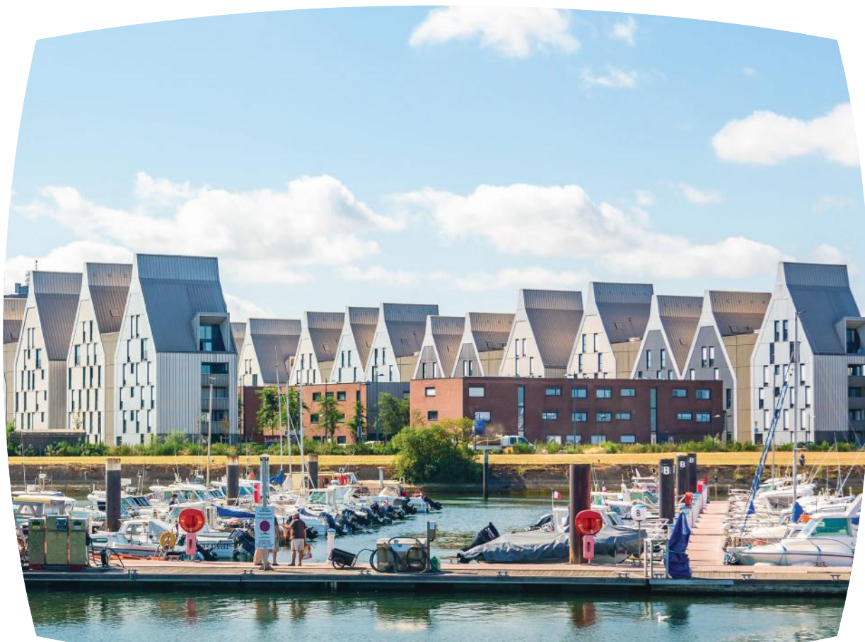
Vue depuis le port de plaisance sur la première résidence des Gables
