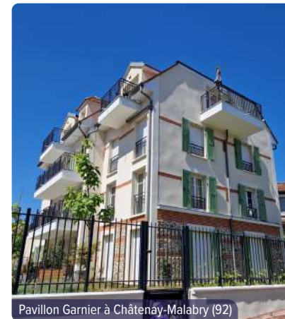
Pavillon Garnier à Châtenay-Malabry (92)
