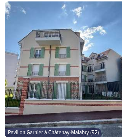
Pavillon Garnier à Châtenay-Malabry (92)
