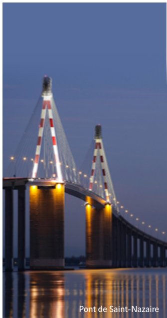
Pont de Saint-Nazaire
