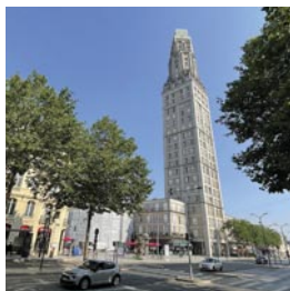
La Tour Perret
