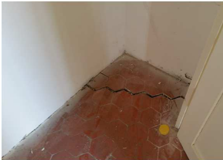
Fissure au niveau des sols près des appuis des planchers – Zone 2 R+2
