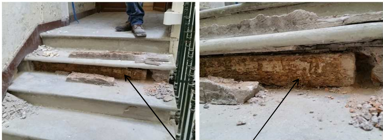
Poutre bois en console encastrée dans le mur
