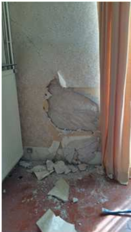
Fissure biaise de l'enduit du mur de façade Est de la zone 7 (R+3)
