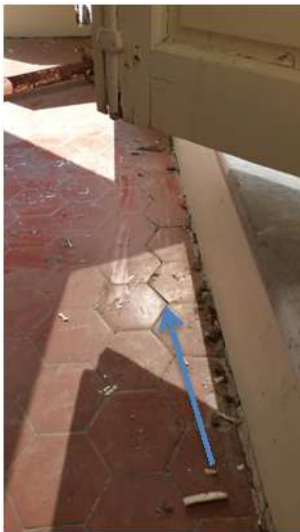
Fissure au niveau des sols près des appuis des planchers – Zone 2 R+2
