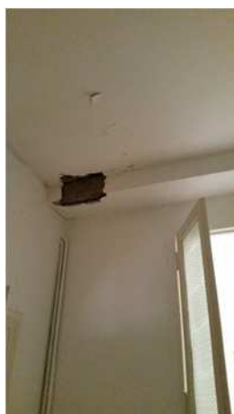
Photos du sondage sur la poutre primaire prise en sous-face (plancher haut R+1)
