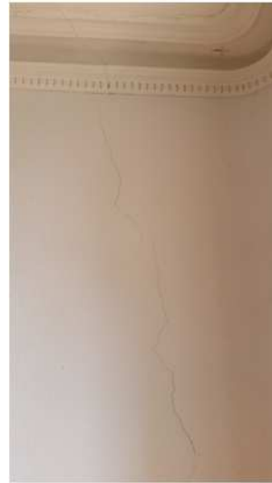
Fissure biaise du doublage du mur refend Nord côté façade de la zone 2 (R+2)
