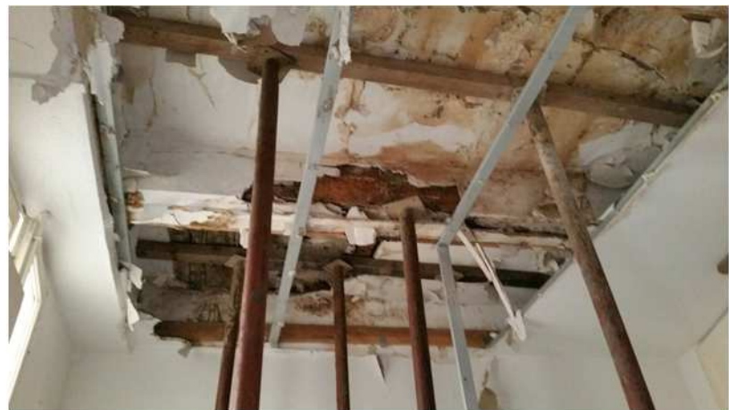
Photos prises en sous-face (en plancher haut R+3)
