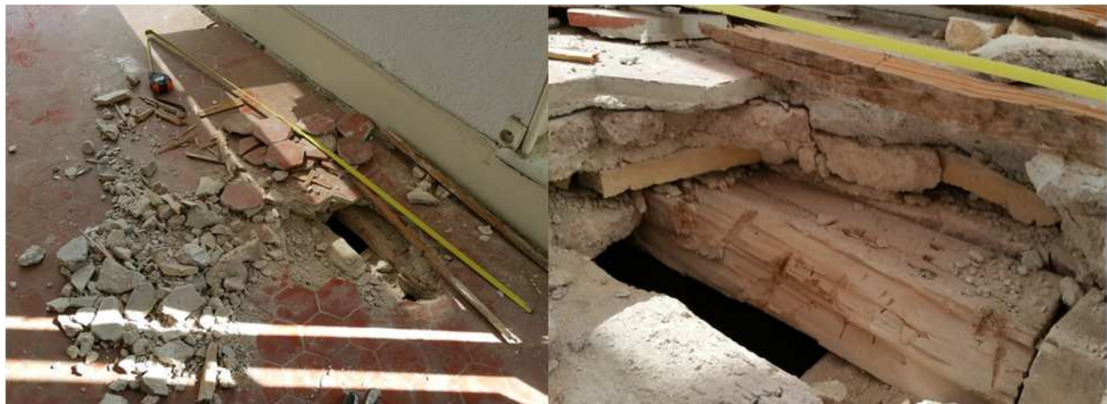
Photos du sondage prises par le dessus (en plancher bas R+2)
