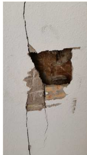
Fissure biaise du doublage du mur refend Sud côté façade de la zone 2 (R+2)
