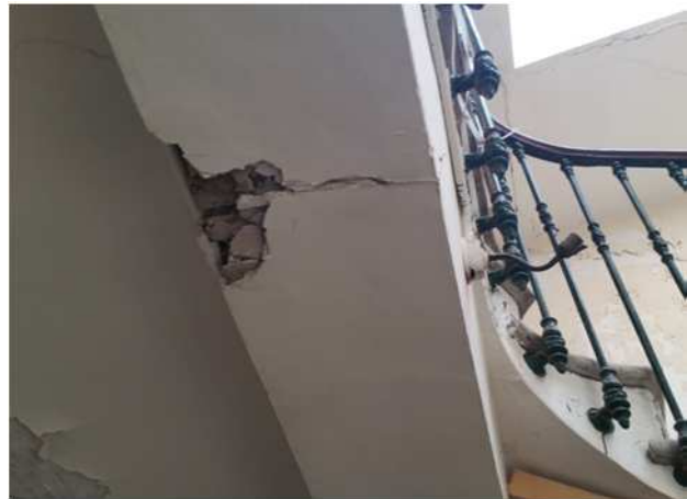
Fléchissement poutre primaire mis en évidence par la fissuration de l'enduit plâtre
