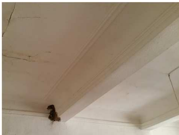
Photos du sondage prise en sous-face (en plancher haut de l'entresol entre R+1 et R+2)
