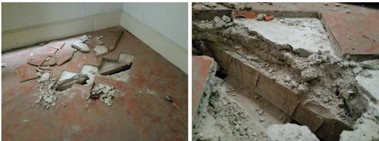
Photos du sondage prise par le dessus (en plancher bas R+2)
