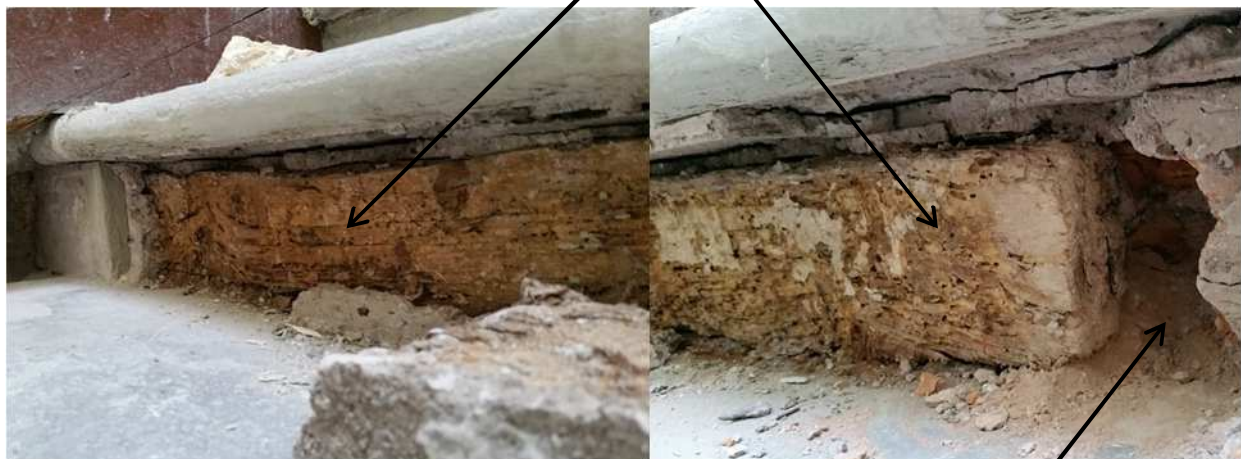
Poutre bois en console encastrée dans le mur
