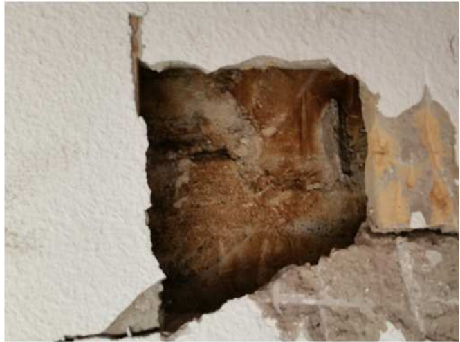
Doublage en briquettes avec enduit
