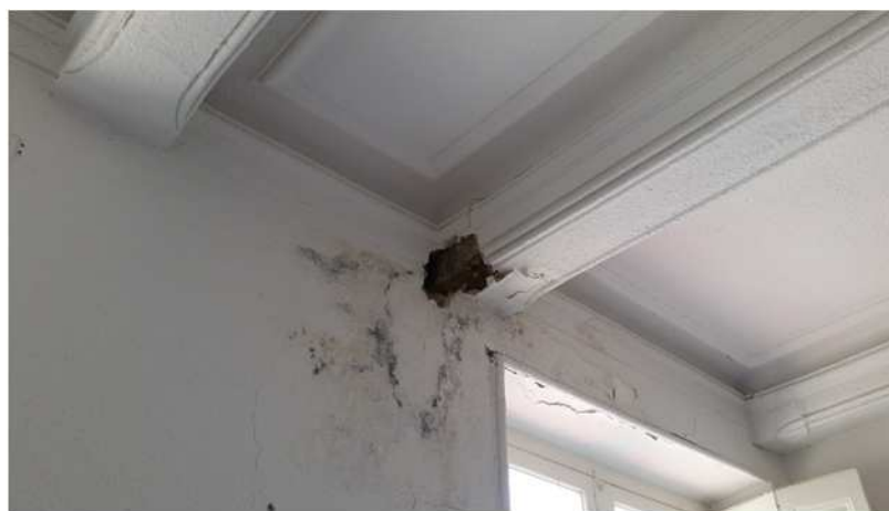
Photos prises en sous-face (en plancher haut R+3)
