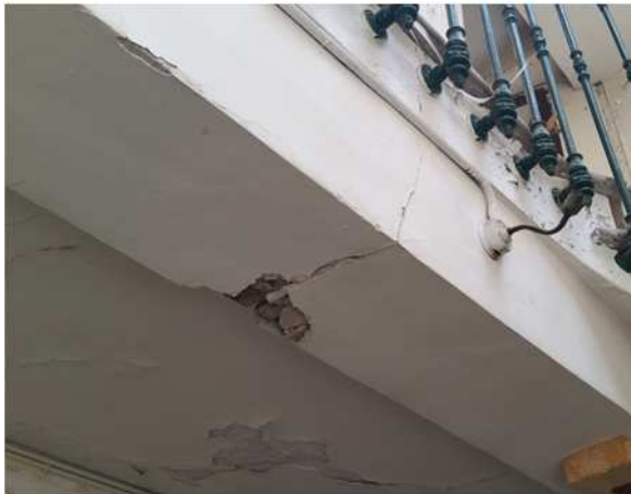
Fléchissement poutre primaire mis en évidence par la fissuration de l'enduit plâtre
