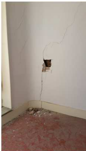
Fissure biaise du doublage du mur refend Sud côté façade de la zone 2 (R+2)
