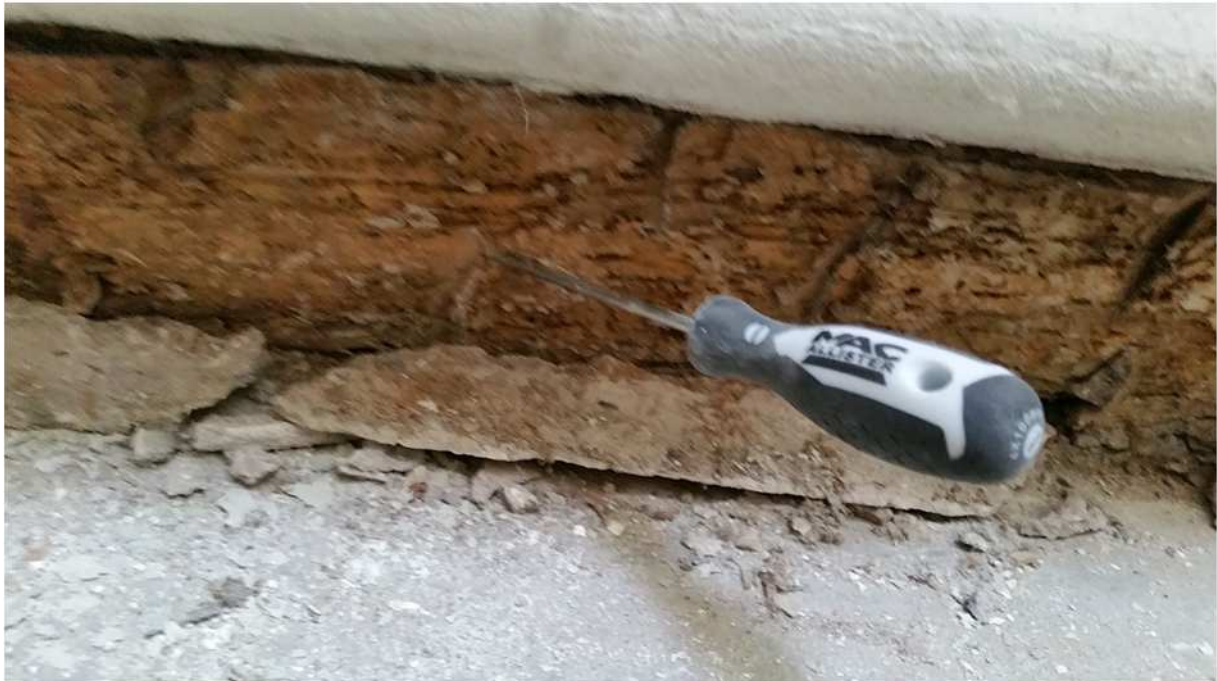
Test d'enfoncement au tournevis : enfoncement de plus de 1 cm
