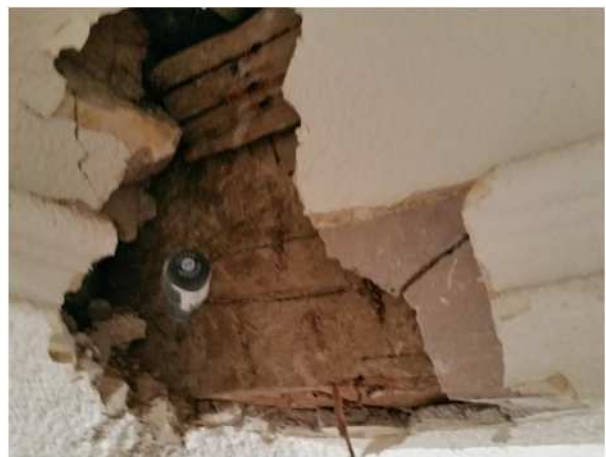
Photos du sondage prise en sous-face (en plancher haut de l'entresol entre R+1 et R+2)
