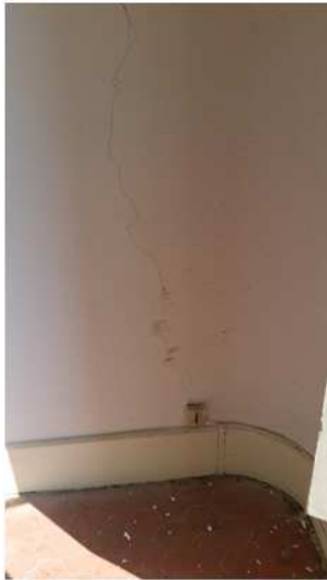
Fissure biaise du doublage du mur refend Nord côté façade de la zone 2 (R+2)
