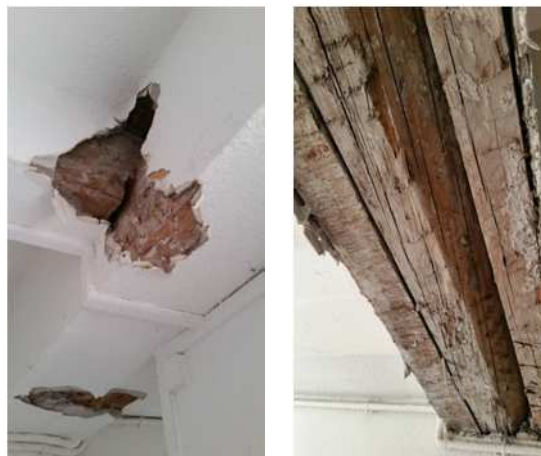
Photos du sondage sur la poutre primaire (sous-face en plancher haut R+3)
