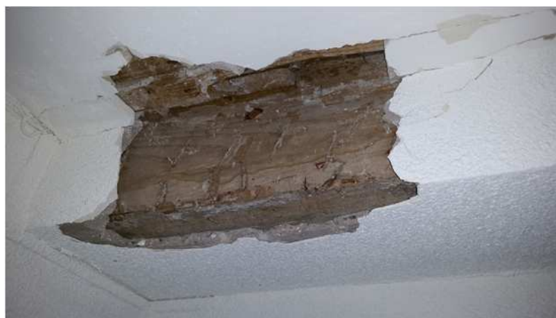
Photos du sondage sur la poutre primaire prise en sous-face (plancher haut R+1)
