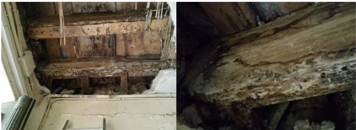
Photos prises en sous-face (en plancher haut RDC)
