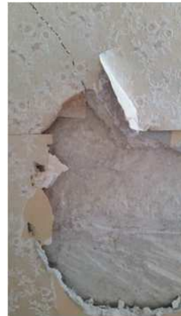
Fissure biaise de l'enduit du mur de façade Est de la zone 7 (R+3)
